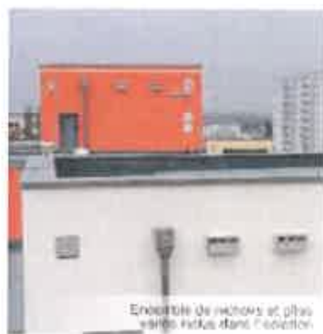
Nichoirs à Moineau domestique et gîte à chauves-souris inclus dans l'isolation d'un bâtiment
