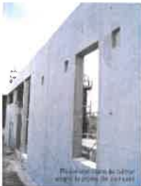
Préparation en phase construction de réserves dans le béton pour recevoir les nichoirs
