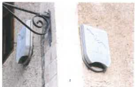
Pose de gîtes à chauves-souris en façade
