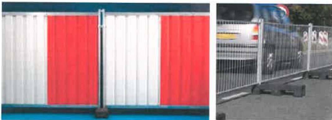
Exemple de clôture fixe et solide (pleine à gauche, grillagée de type HERAS à droite) avec un espace dans le bas permettant le passage de la petite faune
