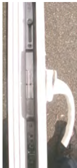
② Fermeture centrale (crémonne et tringle)
