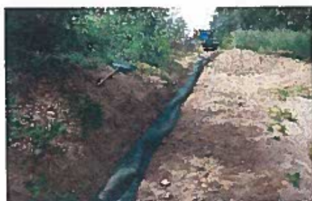
Tranchée pour enfouir la bâche
