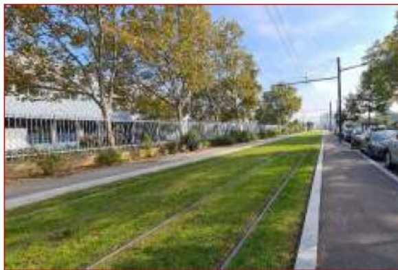
T6 Sud - Plate-forme végétalisée rue Challemel Lacour
