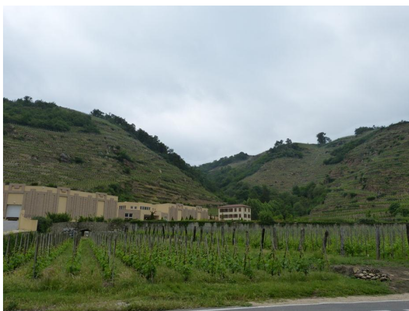
Illustration 10 : Zone à risque de coulées de boue et de chutes de blocs isolées – commune de Tupins et Semons (photo BRGM)
