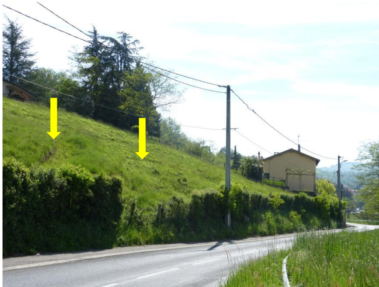
Illustration 8 : Fissures de traction en amont d'une route affectant des formations argilo-caillouteuses dans quartier La Garenne sur la commune de Sain Bel (Photo BRGM)
