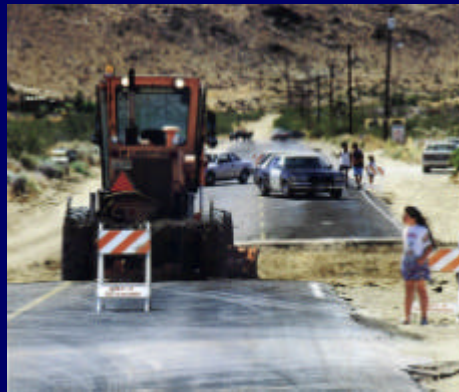
Rejet et décrochement Séisme de Landers, USA 1992
