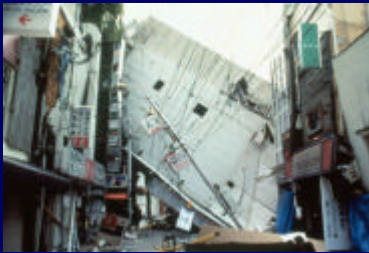
Séisme de Kobé, Japon 1995
